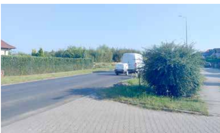
Z uwagi na wysoki krzew rosnący przy drodze widoczność jest znacznie ograniczona
