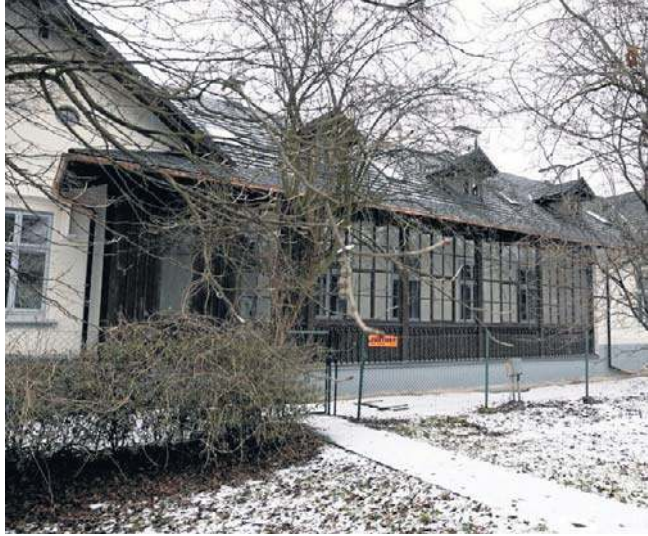
Willa Heleny Modrzejewskiej już odremontowana, ale to nie koniec prac w zabytkowym budynku
