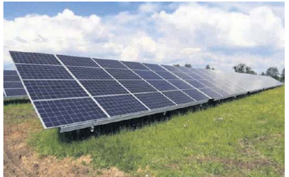
Budowa farmy fotowoltaicznej w Muchowcu prawdopodobnie rozpocznie się już tej jesieni. Fot. ilustracyjne
