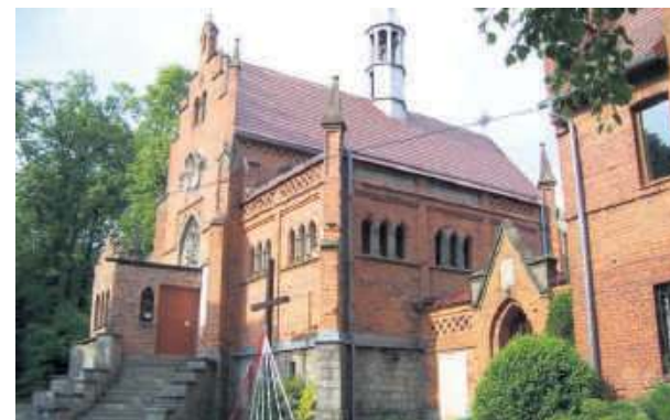
Radni zdecydowali, że niespełna 15 tysięcy złotych zostanie przeznaczonych na konserwację ceramicznego frezu plecionego na elewacji kościoła w Żelowicach
