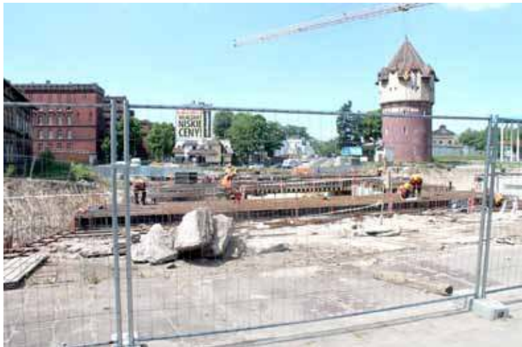
Prace na wiadukcie na Wyszyńskiego wciąż trwają a nowy termin oddania inwestycji do użytku, po opóźnieniach, coraz bliżej....
