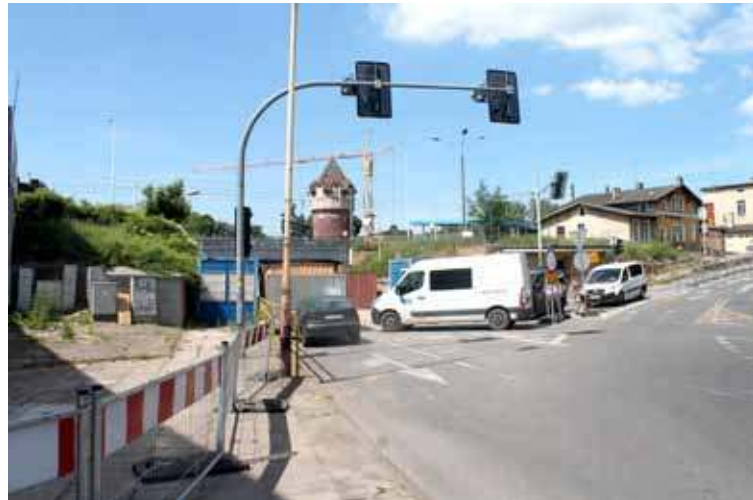
Mieszkańcy naszego miasta z niecierpliwością czekają na moment, w którym znowu będzie można przejechać czy przejść na pieszo na drugą stronę miasta pod tym wiaduktem.
