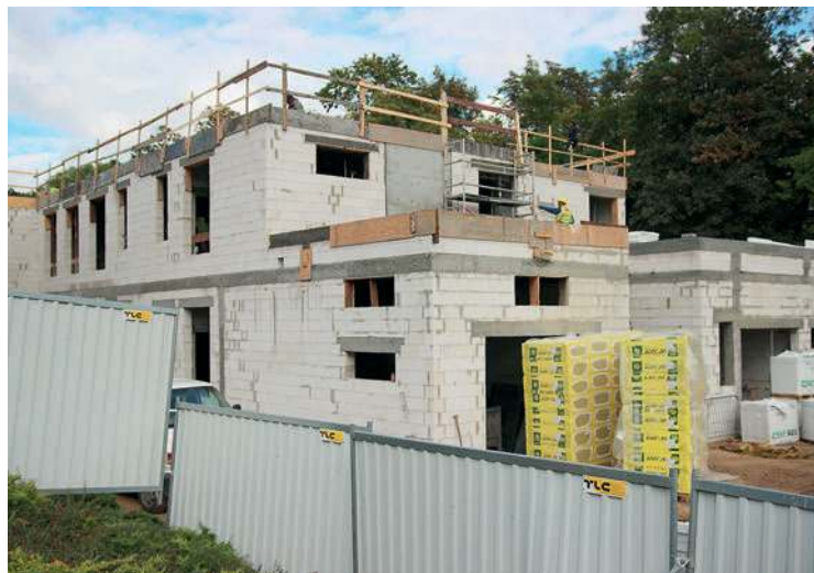
Obecny etap prac budowlanych
