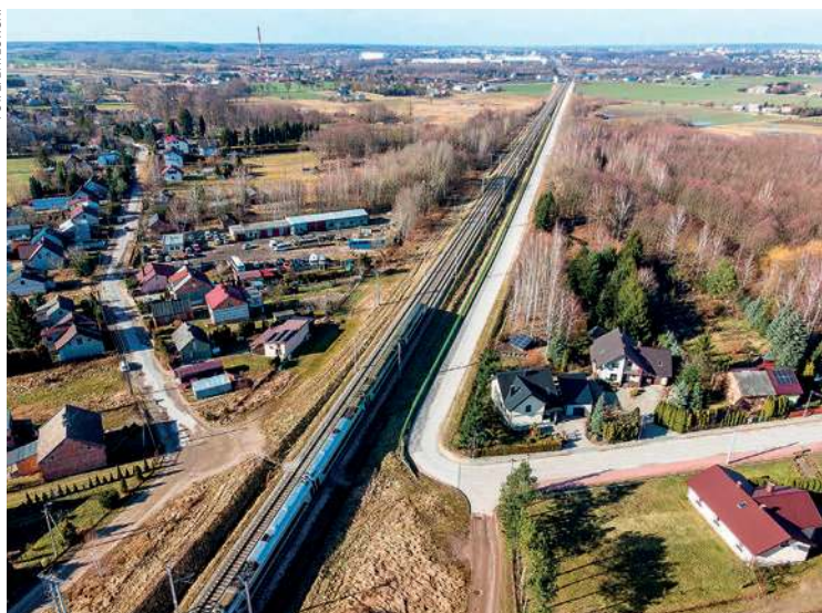
Wiadukt pobudowany zostanie pomiędzy ul. Skłodowskiej-Curie i Ceramiczną
