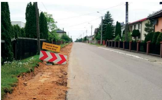
Do końca września ulica ma być wyremontowana
