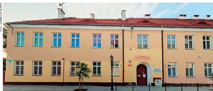
Budynek Jedynki przed rozpoczęciem remontu
