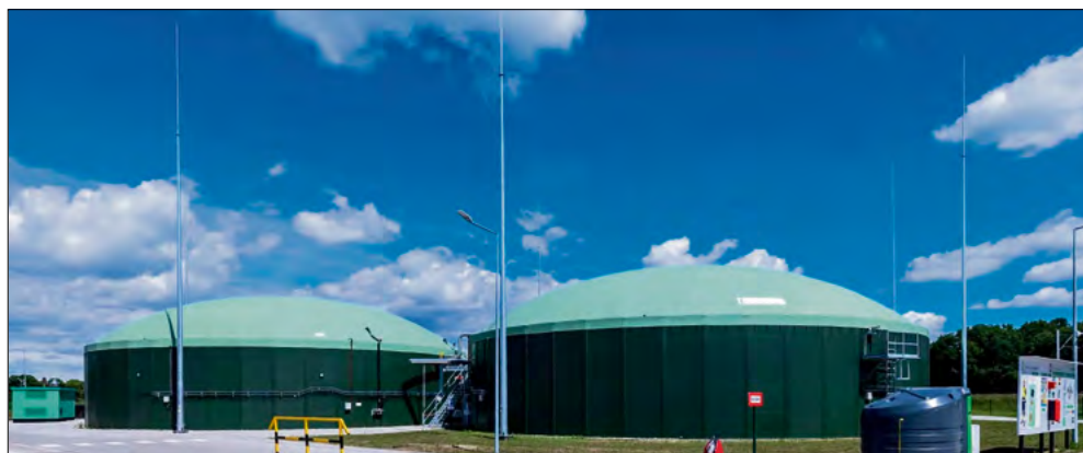
W rolnictwie niewielkie instalacje, zintegrowane z infrastrukturą gospodarstwa, mogą wykorzystywać obornik i inne odpady organiczne, ograniczając ich uciążliwość zapachową i dostarczając poferment, który może być wykorzystany jako nawóz.
