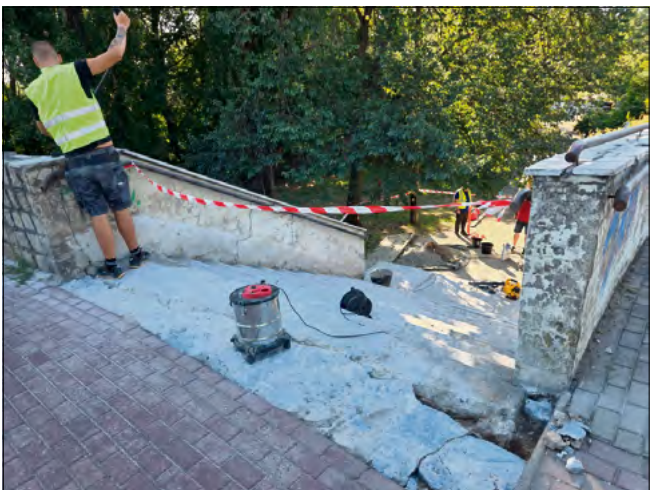
Remont schodów przy moście drogowym w Krapkowicach ma zakończyć się do końca wakacji.
