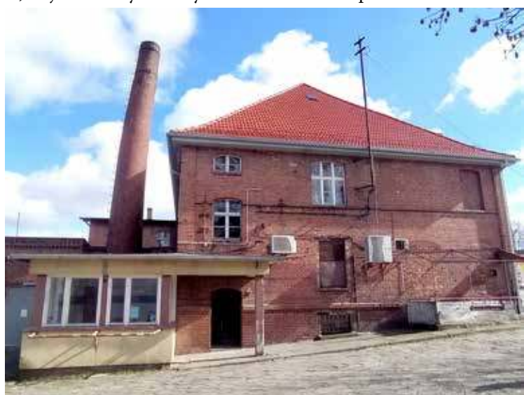
Budynek przy ul. 3 Maja w całej okazałości
