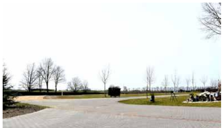
Na nowym cmentarzu zakończyła się budowa kolejnej alejki z kostki betonowej
