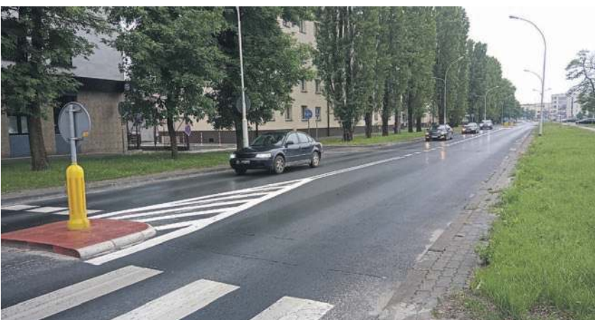
Modernizacji poddany zostanie odcinek drogi od skrzyżowania przy bazylice konkatedralnej do przejazdu kolejowego.
