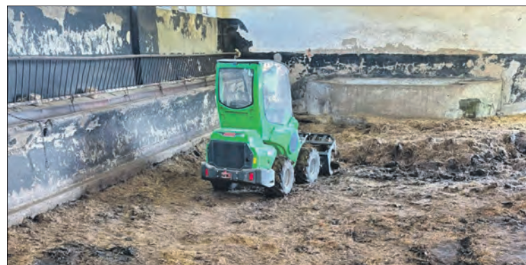
Wnętrze stajni przed uporządkowaniem
