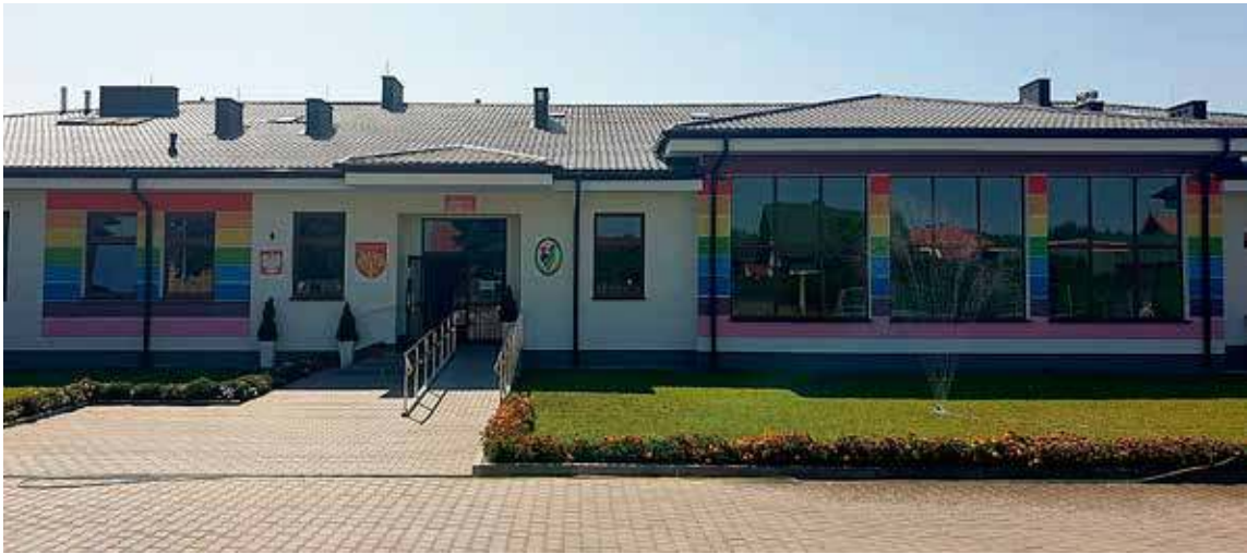
Wejście główne do Publicznego Przedszkola w Sobolewie.
