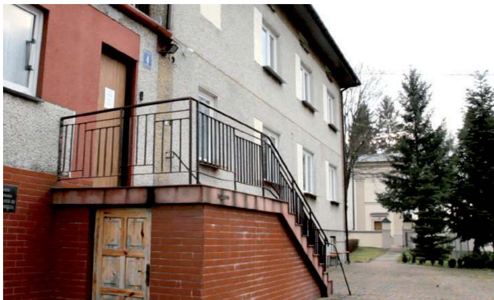
Do kradzieży doszło w godzinach wieczornych na terenie domu parafialnego we Wrzelowcu
