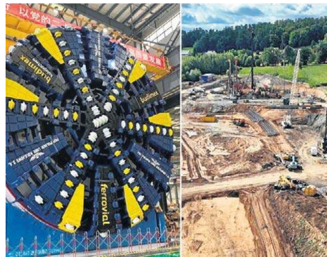
W Chinach trwają ostatnie testy przy tarczy TBM, prace przy budowie nowej linii kolejowej nabierają tempa
