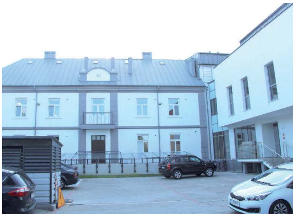
Zakończyła się przebudowa siedziby Urzędu Skarbowego w Lubartowie przy ul. Legionów 55. Od 14 sierpnia siedziba Naczelnika Urzędu Skarbowego w Lubartowie zostaje tam przeniesiona z budynków tymczasowych mieszczących się przy ul. 3 Maja 16 oraz ul. A. Mickiewicza 6.
