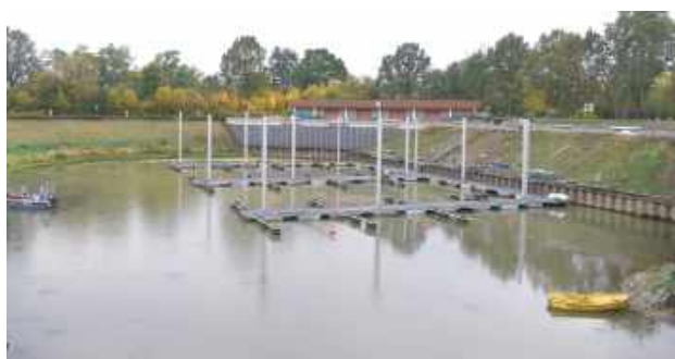
Prace nad modernizacją rozpoczęły się kilkanaście tygodni temu. Do tej pory wykonano m.in. część pomostów czy część oświetlenia i monitoring. Wszystko ma być gotowe do 20 grudnia
