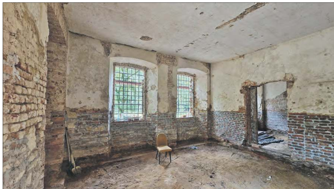
Jeszcze kilka tygodni temu zamiast jednego, były tu dwa pomieszczenia. Ścianki zbudowano po II wojnie światowej, kiedy w części pałacu utworzono mieszkania pracowników PGR-u.
