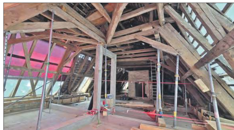
Strych remontowanego skrzydła z częściowo zdjętymi dachówkami i wylanym betonem stropu
