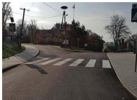
Droga w miejscowości Czerniki po przebudowie
