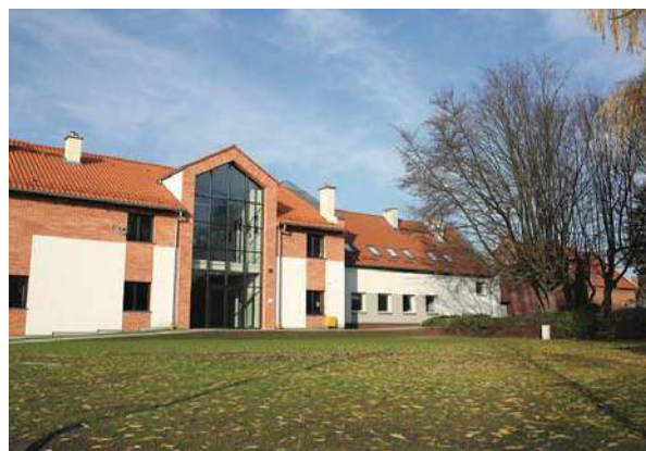
Remont budynków LSP
