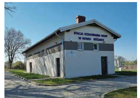
Stacja Uzdatniania Wody w Nowej Różance po przebudowie
