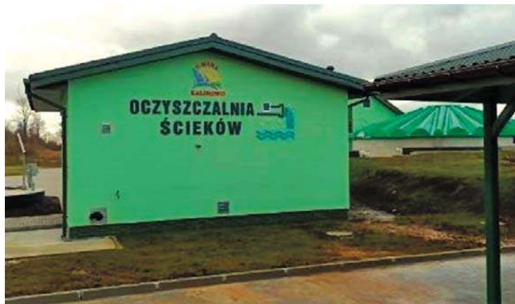
OCZYSZCZALNIA ŚCIEKÓW W KALINOWIE
