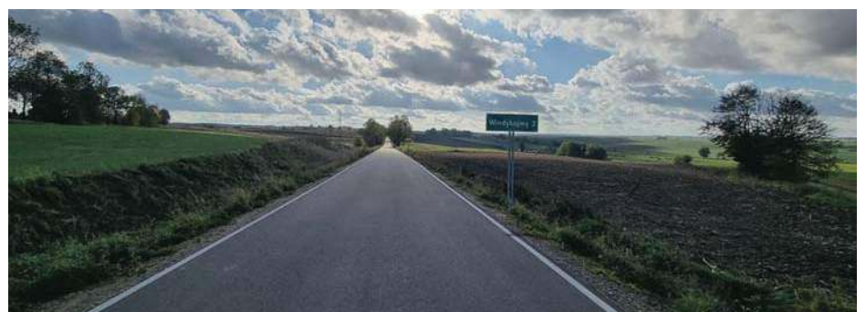
Droga w miejscowości Windykajmy po przebudowie
