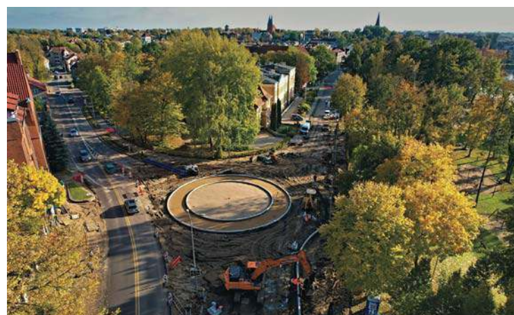
Budowa ronda na przecięciu ulic Mickiewicza i Olsztyńskiej w Ostródzie (fot. Wiesław Ruczyński)
