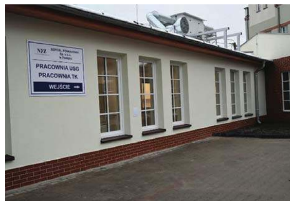
Budynek Pracowni TK
