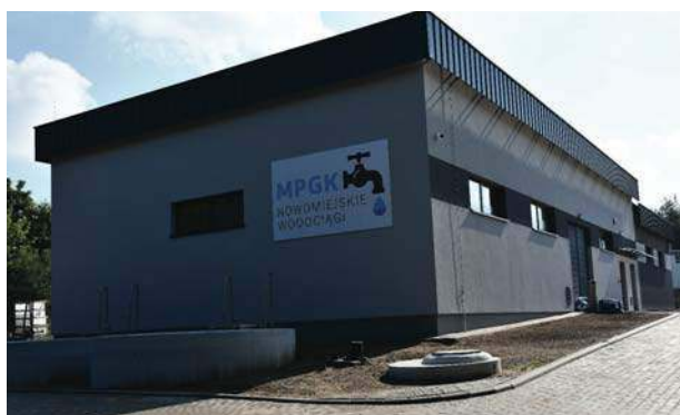
Nowa stacja uzdatniania wody
