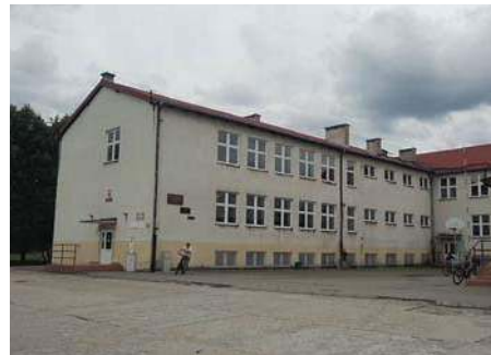
Szkoła Podstawowa w Wilkowie przed termomodernizacją
