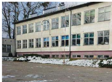
Szkoła Podstawowa w Nakomiadach przed termomodernizacją
