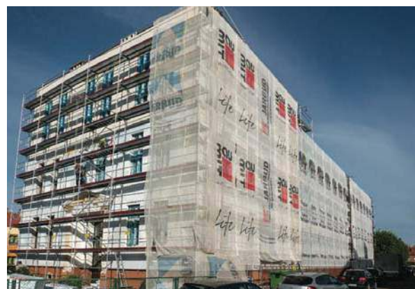
Termomodernizacja w ZS
