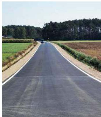
Przebudowa drogi Gnojno – Zakrzewo
