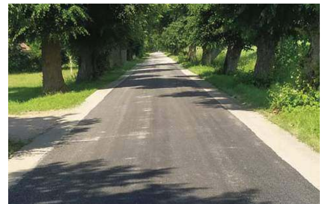
Wyremontowana droga powiatowa
