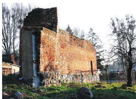
MURY W PASŁĘKU DO REMONTU \2
