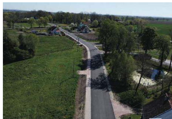
Remont drogi w Fiszewie
