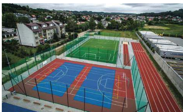
Kompleks sportowy przy SP nr 1
