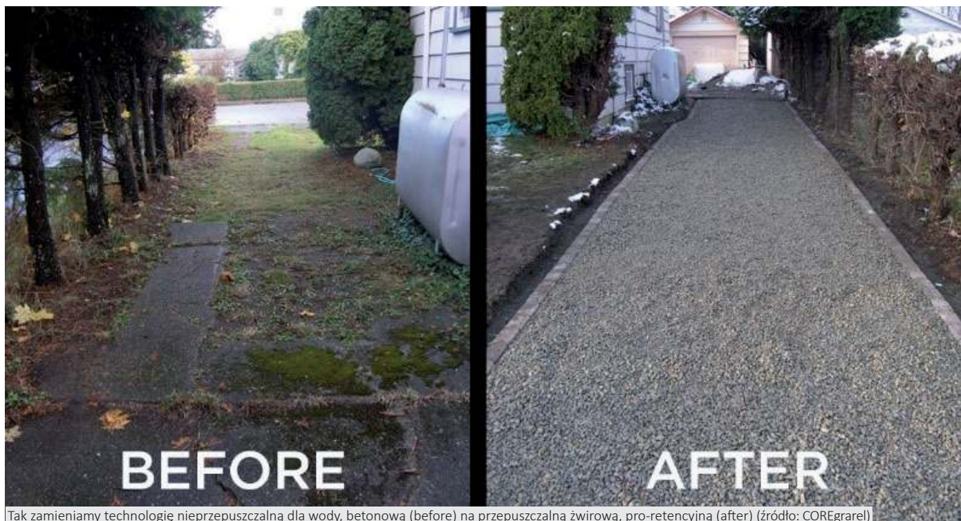
Tak zamieniamy technologię nieprzepuszczalną dla wody, betonową (before) na przepuszczalną żwirową, pro-retencyjną (after) (źródło: COREgravel)
