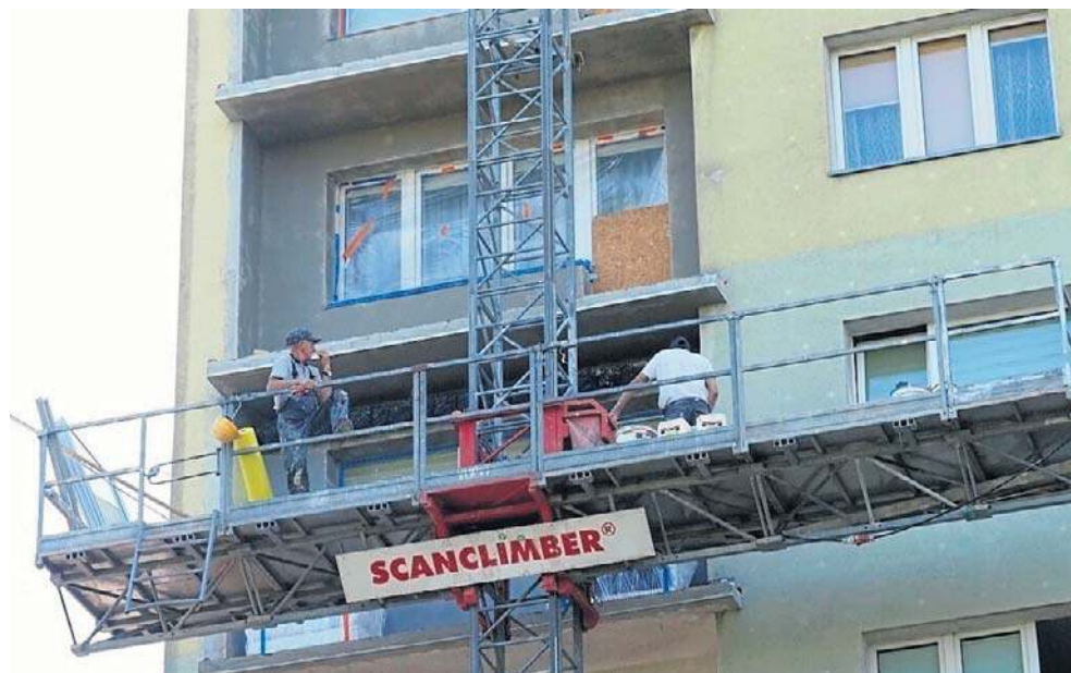
Tak teraz wygląda zabezpieczenie balkonów w blokach na Widzewie Wschodzie. Remont w tym budynku ma potrwać do końca sierpnia
