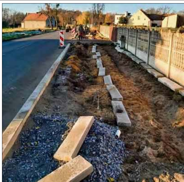
W Dobrej powstaje nowy chodnik.
