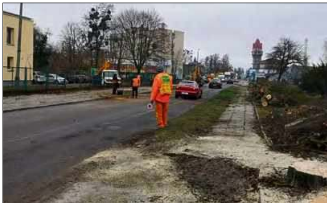
Od 30 listopada przejazd Opolską jest utrudniony.
