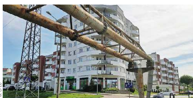
W Elblągu trwa modernizacja sieci ciepłowniczej
