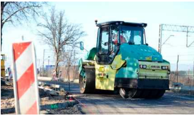
Remont pierwszego odcinka ulicy Dworcowej zbliża się ku końcowi. Mieszkańcy mają nadzieję, że w przyszłym roku to samo stanie się z drugim, jeszcze bardziej zdezastrowanym odcinkiem od granicy lasu do rogatek miasta
