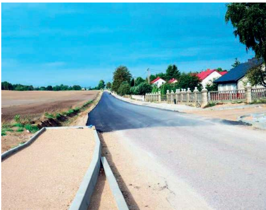
Odcinek remontowanej drogi
