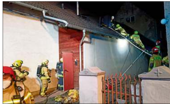
Aby ugasić pożar, strażacy musieli dokonać częściowej rozbiórki dachu.
