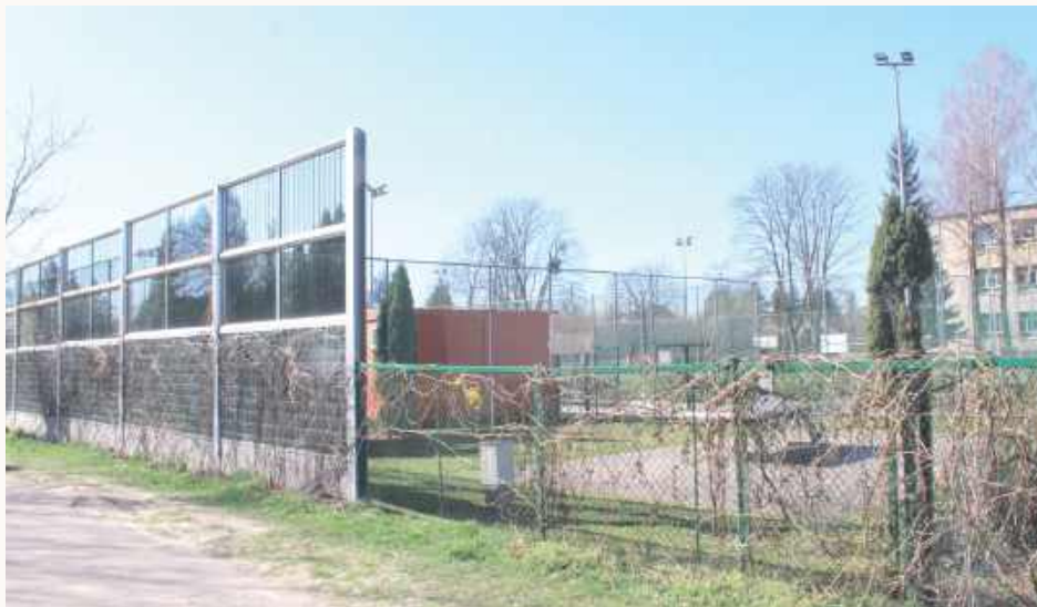
Nawet ustawienie ekranów akustycznych, na które miasto wydało kilkaset tysięcy złotych, nic nie dało
