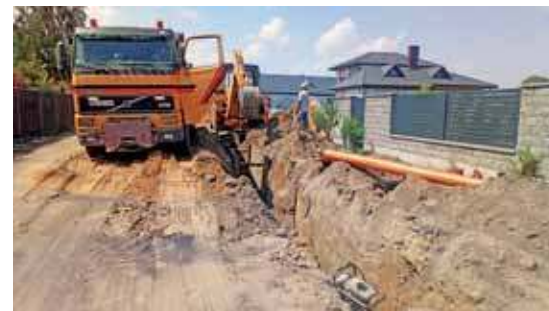
Budowa sieci kanalizacyjnej Osiedle Śniegockiego
