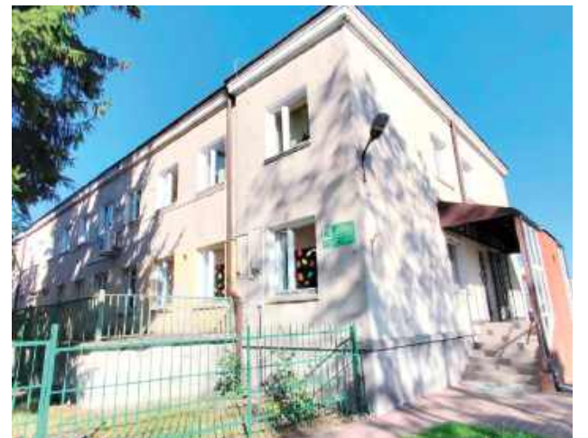
Obecny budynek opolskiego KRUS-u znajduje się przy ul. Fabrycznej i pozostawia wiele do życzenia. Jest w nim ciasno, a na dodatek nie jest przystosowany do potrzeb osób z niepełnosprawnościami
