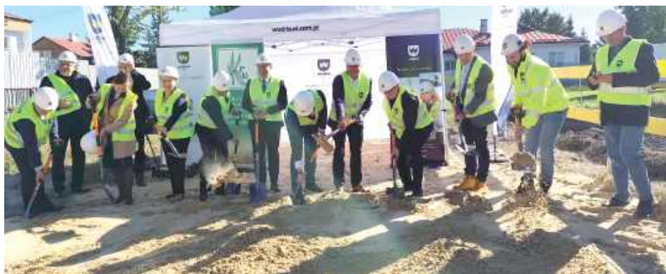
Kulminacyjnym momentem wydarzenia było symboliczne wbicie łopaty na działce przy ul. Kolejowej. To właśnie tam, na powierzchni 0,13 ha, powstanie nowoczesny obiekt użyteczności publicznej
