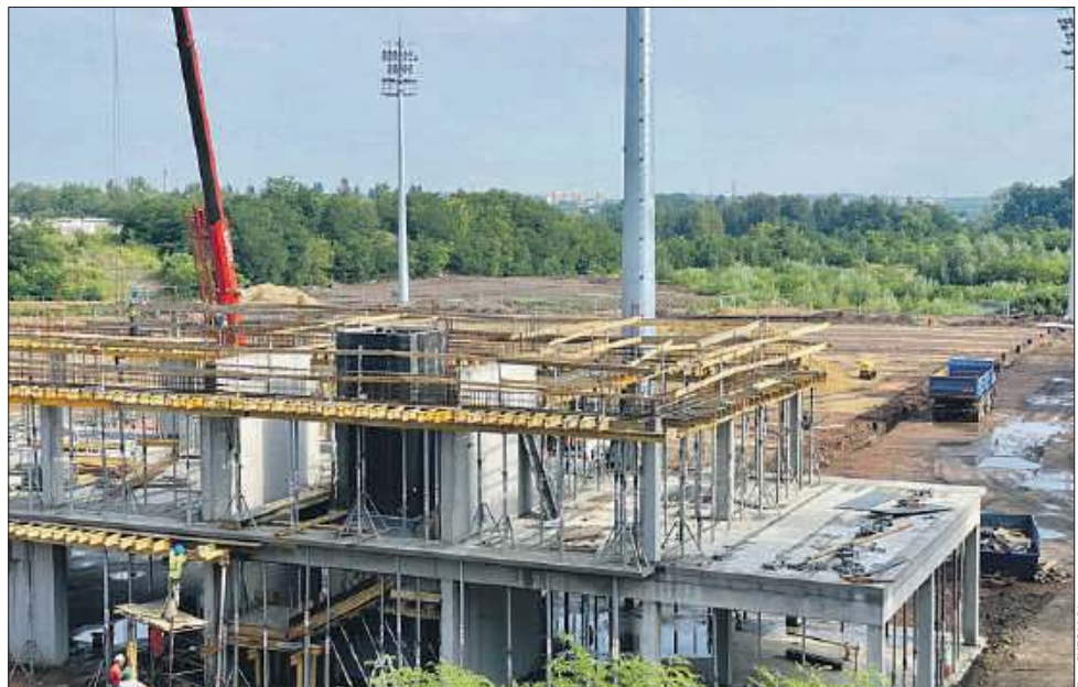
W połowie roku rósł budynek oraz szykowano teren pod boisko
