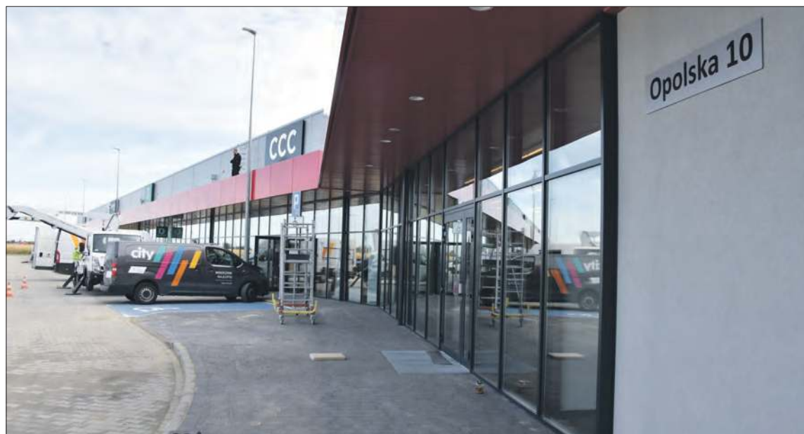
Na terenie parku handlowego wciąż prowadzone są prace budowlane
