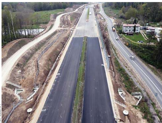
Odcinek S16 Borki Wlk. – Mrągowo ma być gotowy w III kwartale tego roku
