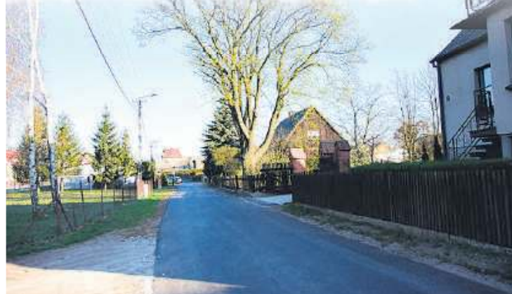
Nowa nawierzchnia. Mieszkańcy od dawna czekali na remont tego odcinka.
