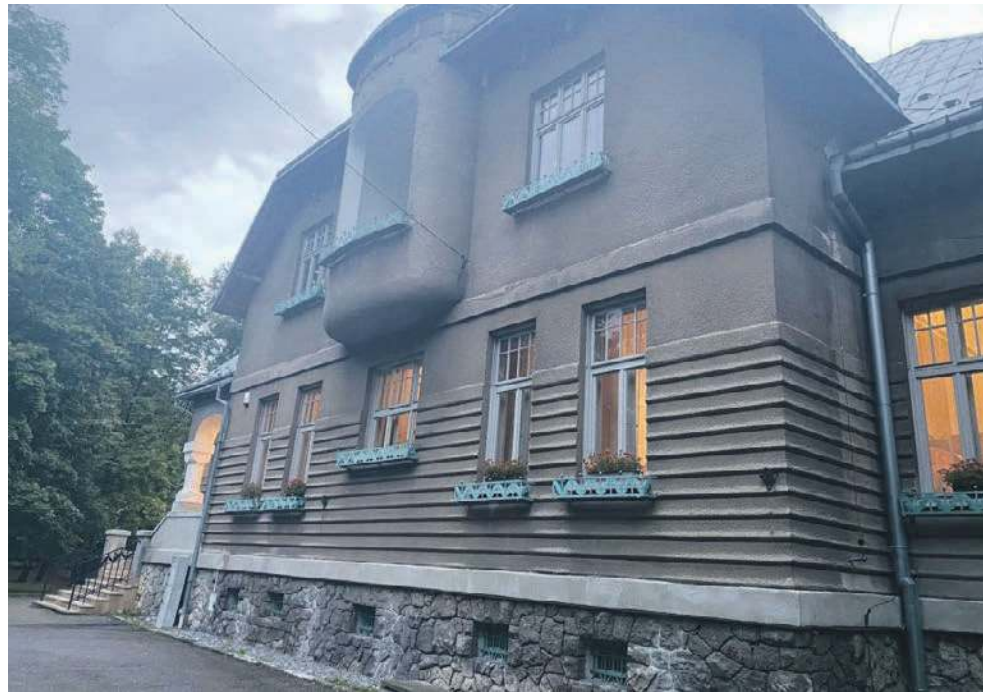
Willi NOT przydałaby się wymiana instalacji, remont węzłów sanitarnych oraz salonów dworku
