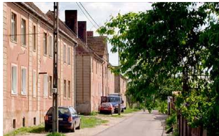
Unikatowa zabudowa kolejowej osady fot. Jan Stoncel Photography
