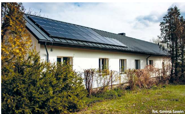
Świetlica wiejska, czyli obecna filia Gminnego Ośrodka Kultury w Sawinie, przeszła gruntowny remont.
