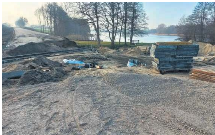
1 grudnia miejsce przepustu w Wępinie na drodze powiatowej numer 1030C relacji Bystaw – Cekcyn było całkowicie rozkopane. Prace w ostatnich tygodniach szły do przodu, ale jeden z wykonawców nie zmieścił się w planowanym terminie. Fot. Tadeusz Dalecki
