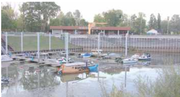
Inwestycja w Marinie przewiduje m.in. wykonanie robót czerpalnych oraz wydobywanie i zagospodarowanie namułu (osadu) z dna basenu portowego
