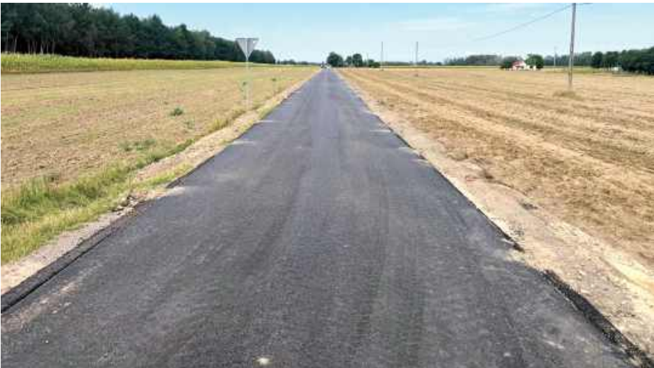
Następną miejscowością, w której pojawi się nowa nawierzchnia, będzie Białka. Tam planowana jest modernizacja aż 650-metrowego odcinka drogi
