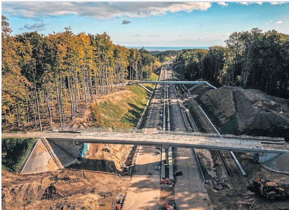
Prace są bardzo zaawansowane
