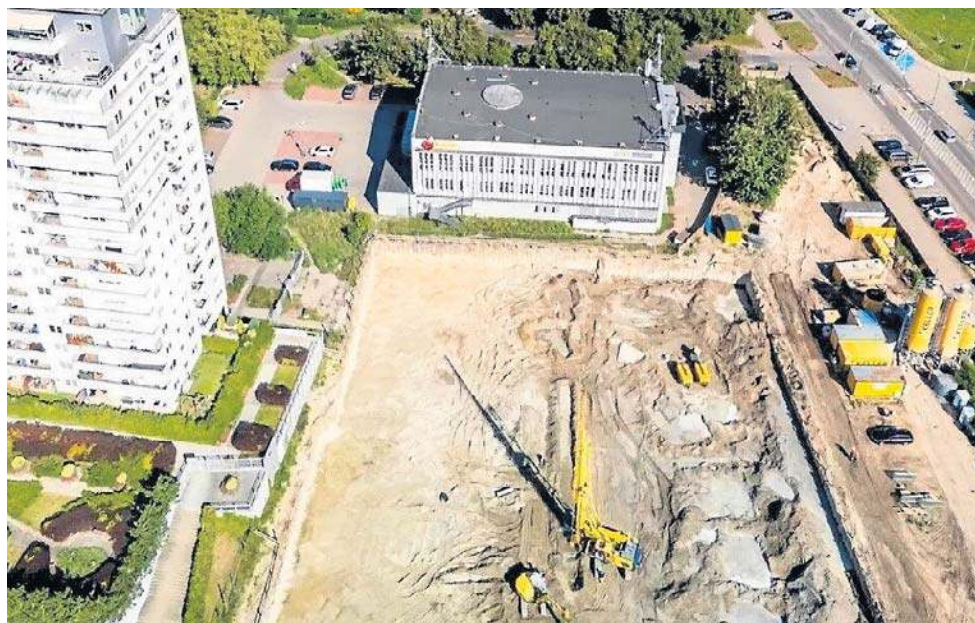
Trwają specjalistyczne prace przy budowie Big Boya
