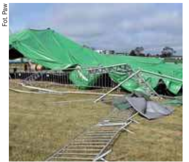
Zniszczone obiekty w Poświętnem
