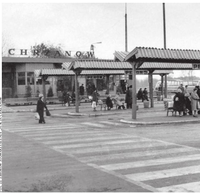
Dworzec PKS przy ul. Trzebińskiej w Chrzanowie po rozbudowie w 1979 r.
