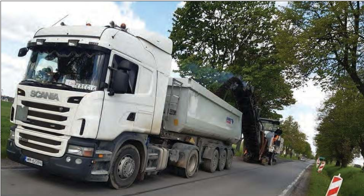
Wyremontowanym odcinkiem kierowcy będą mogli cieszyć się w lipcu. Tymczasem drogowcy proszą o zachowanie szczególnej ostrożności
