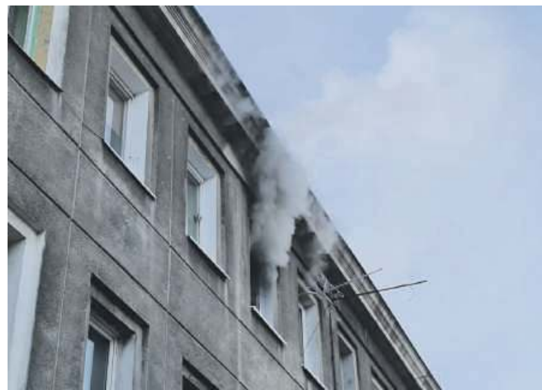
Mieszkanie na drugim piętrze spłonęło doszczętnie
