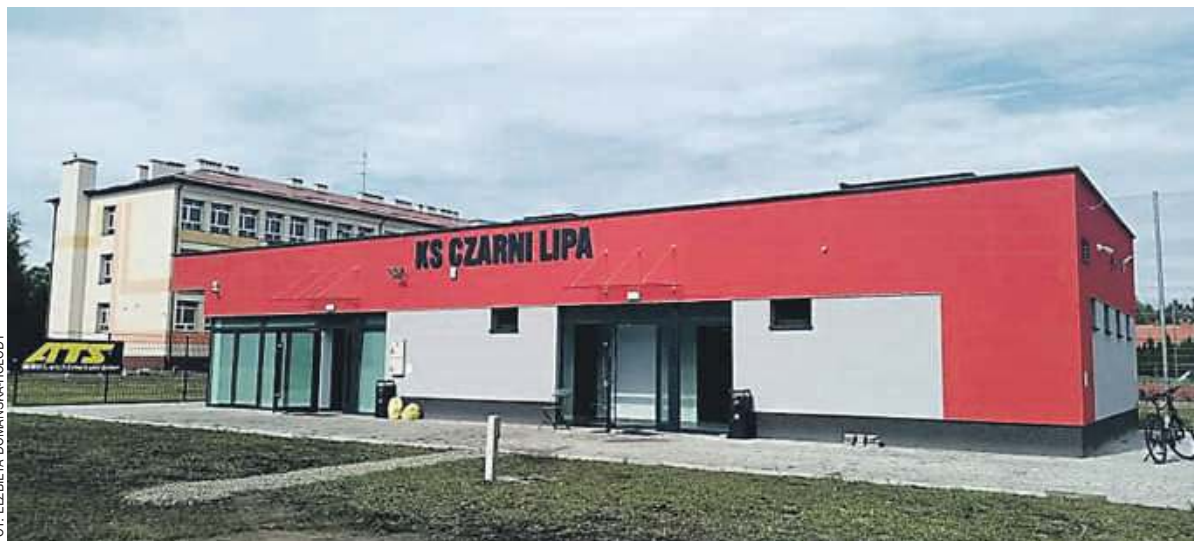
Zaplecze sanitarno-szatniowe na obiekcie sportowym w Lipie
