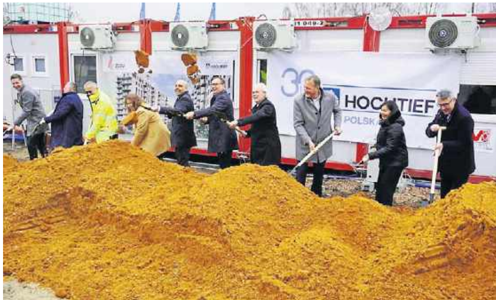
Symboliczne rozpoczęcie budowy 405 nowych mieszkań komunalnych w Żorach
