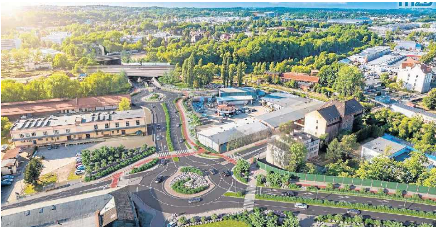
Realizacja pierwszego etapu inwestycji zajmie około 20 miesięcy. Jest szansa, że podpisanie umowy z wykonawcą nastąpi jeszcze w tym roku
