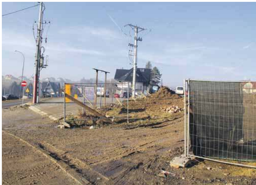
Nowy market już powstaje u wylotu ul. św. Anny.
