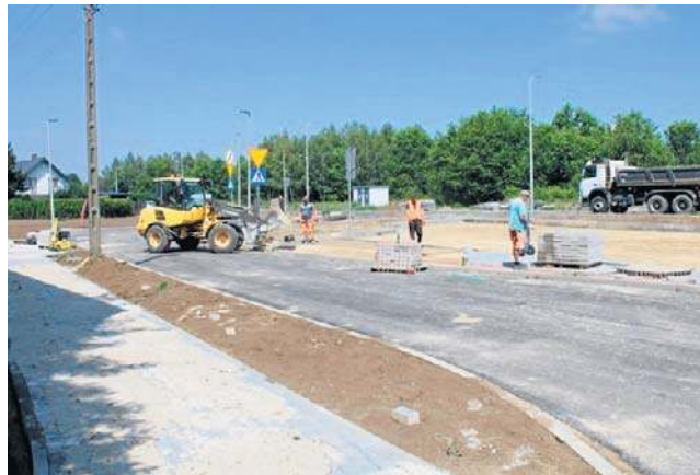
Rozbudowa strefy inwestycyjnej w Radomsku na ukończeniu
