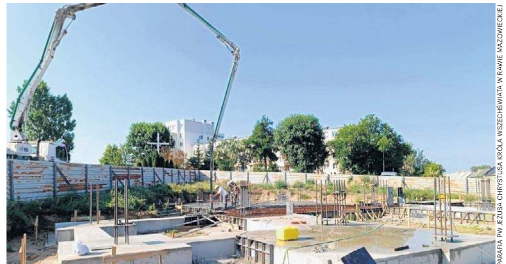
Ekipy wylały już fundamenty pod budowę świątyni
