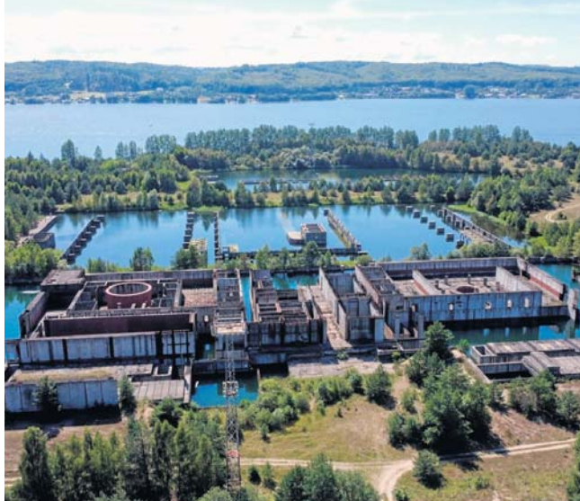
W 1990 r. rząd przesunął inwestycję „Elektrownia Jądrowa Żarnowiec w budowie” w stan likwidacji
