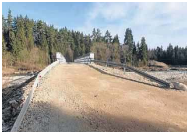
Most tymczasowy posłuży do czasu oddania do użytku nowego mostu na Białce, który jest w trakcie budowy
