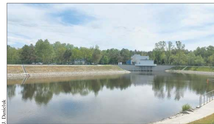
Tak wygląda ujęcie wody „Grabówka” po modernizacji
