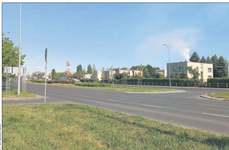
Al. Piłsudskiego czeka remont. Prace mają być prowadzone na odcinku od ul. Otołińskiej do Jesiennej
