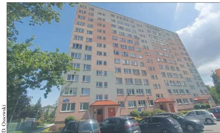
Blok przy ul. Zgliczyńskiego
