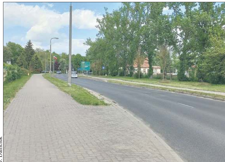
Zwiększenie środków finansowych potrzebnych na remont ul. Łukasiewicza pozwoli na realizację inwestycji
