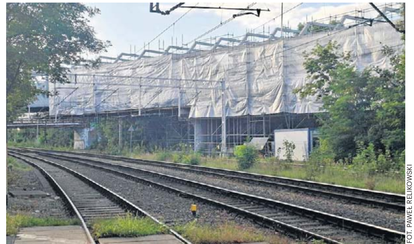
Ogromne rusztowanie stanęło przy TAT na Nowy Dwór
