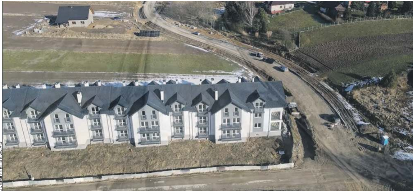
(E) Budowa nowej drogi w Krzeszowicach
